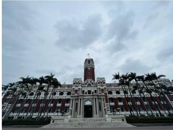
中に入ると、説明して下さるガイドさんと合流し、見学がスタートしました。最初の展示は、總統府の構造についてでした。現在の總統府が日本統治時代に台湾總督府として建設される際、設計は二段階の公募によって決定され、長野宇平治の設計に基づいて建設が開始、その後森山松之助によって気候や材料調達の観点から設計に修正が加えられました。建物の主要構造はコンクリートと煉瓦造りで、地震の多い台湾に適した日本型の平面構成になっています。建物を上から見ると漢字の「日」の形になっているのが印象的でした。また、總督府には竣工当時から電気、空調、エレベーターなどが導入されており、近代的設備を完備した台湾で最初の建物だと言われています。
